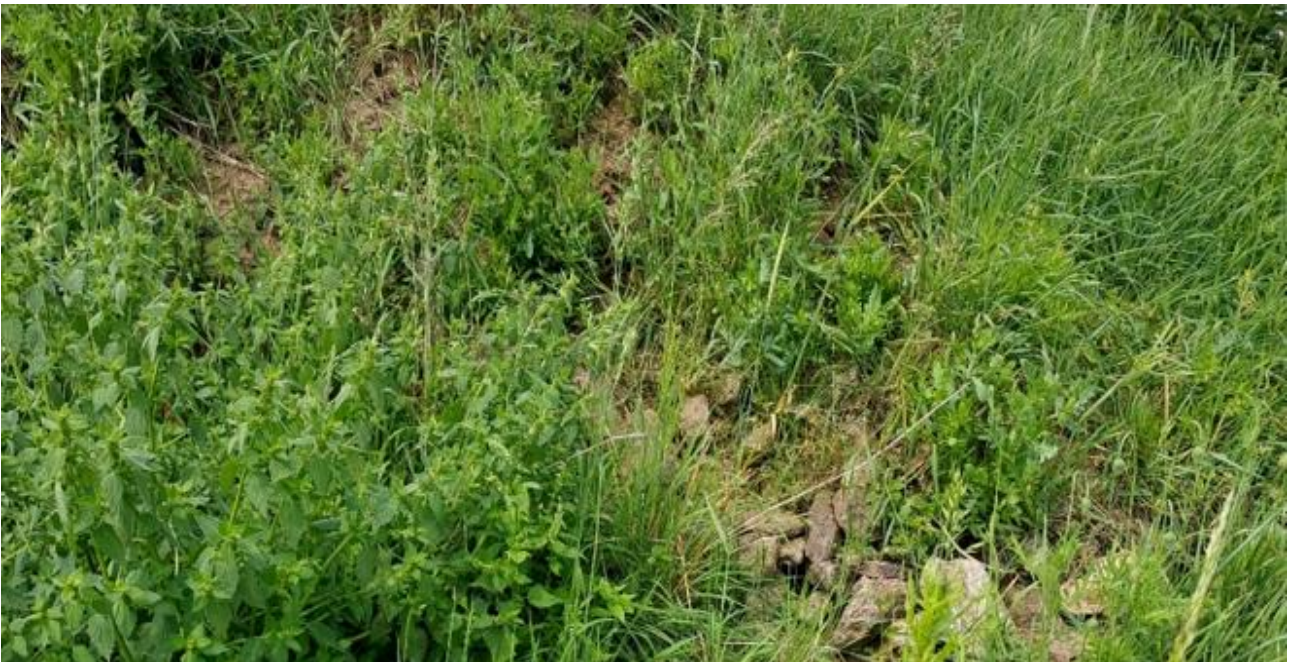
Abbildung 6: Rohboden, Steine und Vegetation am Erdwall; (Foto: M. Tank)
